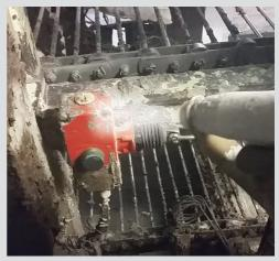
La sabbiatura criogenica è un metodo di pulizia che utilizza il ghiaccio secco (CO2 compresso in forma solida) come sostanza pulente. Questo sistema consente operazioni senza scarti e senza alcuna tossicità, eliminando le abrasioni dovute ai metodi tradizionali.
