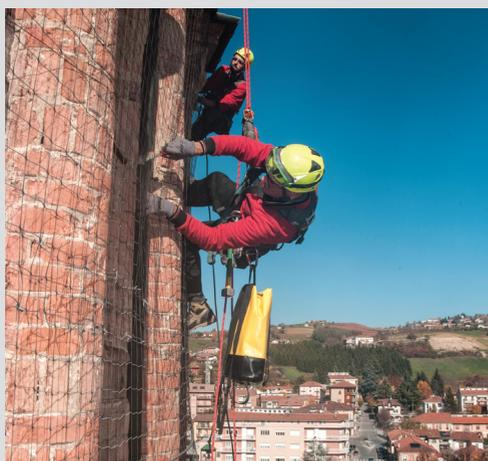
Posizionamento delle linee vita, dissuasori volatili, installazione canne fumarie e sostituzione o riparazione gronde e pluviali.
